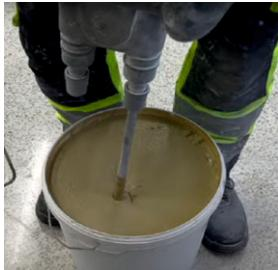
Каждый последующий замес должен быть равен по времени (все замесы должны быть равны по времени). Особое внимание уделять тщательному перемешиванию материала в зоне дна и стенок ведра во избежание дефектов покрытия (плохо перемешанные компоненты и комки сухой смеси не полностью вступают в химическую реакцию).
