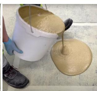
Важной особенностью материала является скорость протекающих реакций и, как следствие, ограниченное время обработки. При недостаточной оперативности в проведении работ, на поверхности могут оставаться следы от распределения или обработки.
